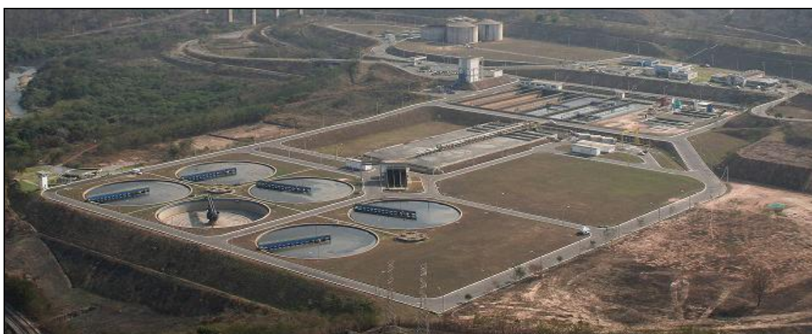
Figura 3: Vista aérea da ETE Arrudas – Tratamento Primário e secundário.
