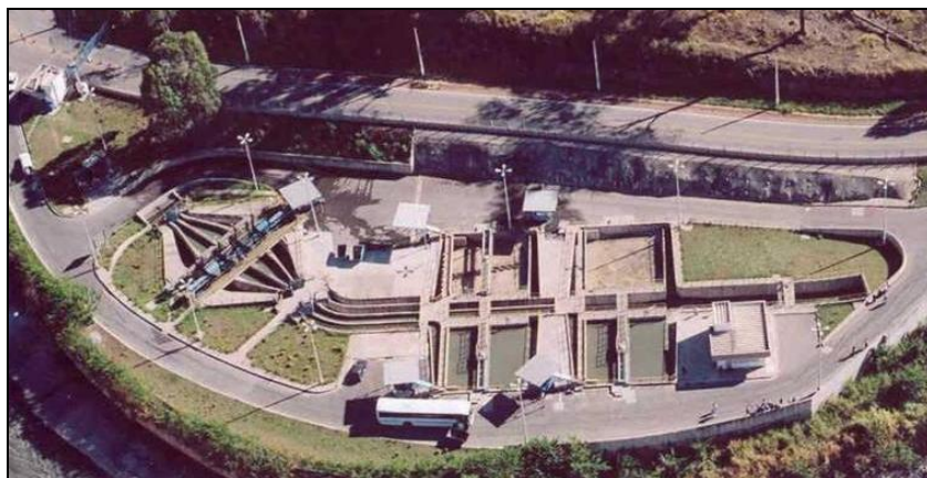
Figura 2: Tratamento Preliminar ETE Arrudas.
