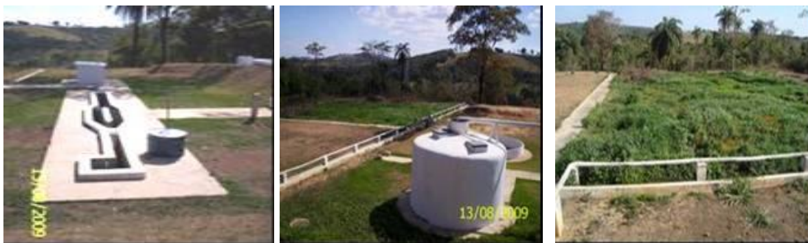
Figura 1 – Vista da ETE APAC – Tratamento preliminar, UASB seguido de OF.
