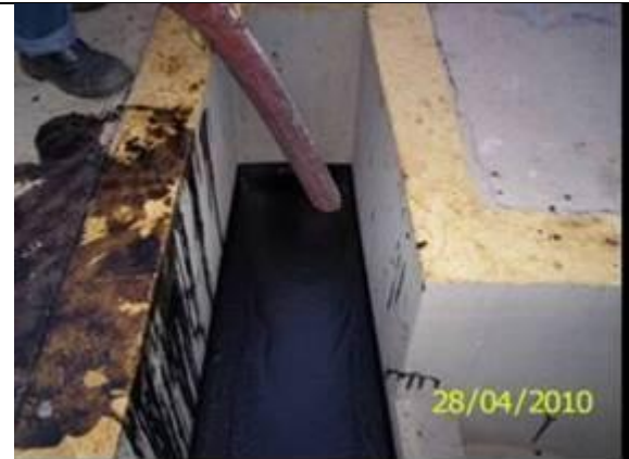
Figura 3 – Sucção do óleo retido no gradeamento da ETE.
