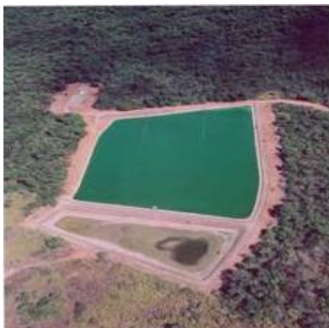
Figura 1 – Vista aérea da ETE Confins.
