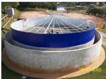
Figura 19: Montagem cobertura do filtro biológico
