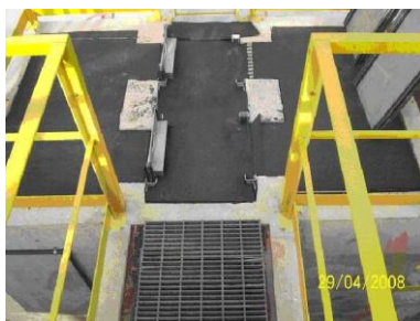
Figura 11: Cobertura das caixas de distribuição de vazão de n.º 2, localizada sobre os Reatores UASB
