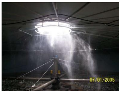
Figura 20: Dosagem do desodorizador na cúpula da cobertura do filtro
