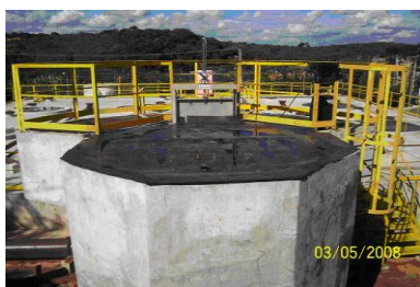
Figura 13: Cobertura da caixa de distribuição de vazão de n.º1 que envia os esgotos para os reatores
