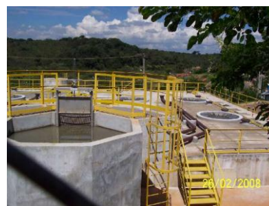
Figura 3: Reatores UASB
