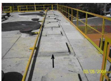
Figura 16: Serviço feito no canal do efluente do UASB
