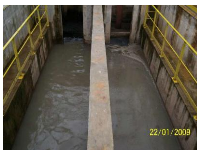
Figura 2: Desarenador
