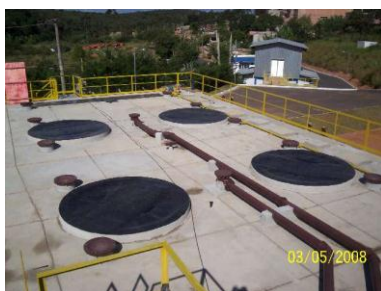
Figura 14: Cobertura das caixas de distribuição de vazão de n.º 3, localizada sobre os Reatores UASB
