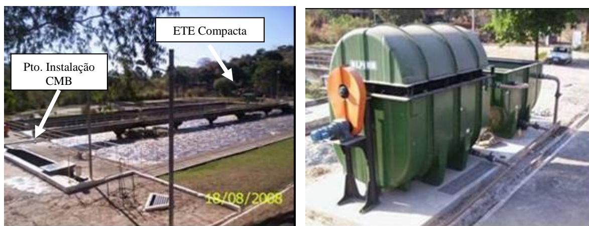
Figura 1 – Localização da ETE – Compacta DBR instalada na ETE Morro Alto.
